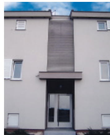
Skrite klimatske naprave nad vhodom
