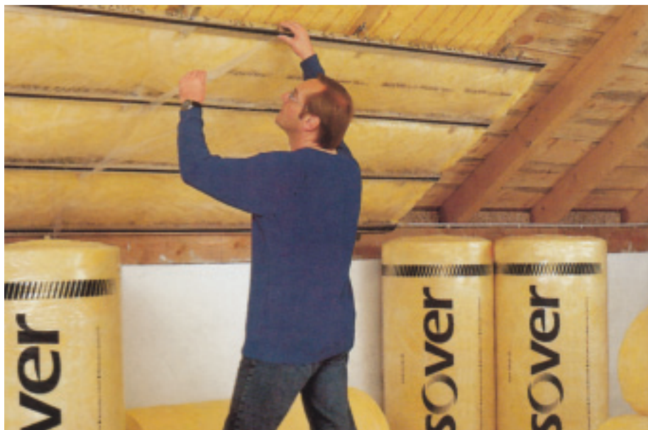
Izolacija strešne konstrukcije
