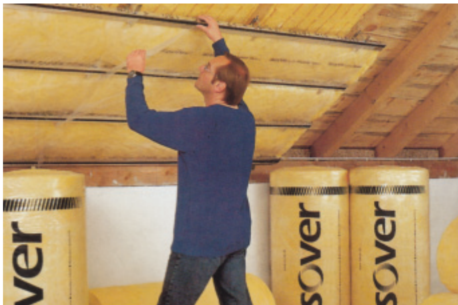
Izoliranje krovne konstrukcije
